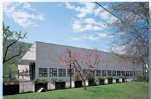
Das Hauptwerk von Metal Work / Produktionsgebäude in Concesio
